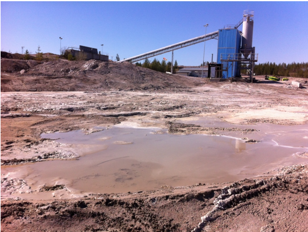
Figur 4. Provtagningspunkt vid Skanskas anläggning i spoldamm där vattnet från betonglastbilarna samlas efter rengöring av lastbilarnas betongtankar.
